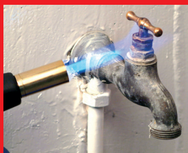
Dégel de canalisations
